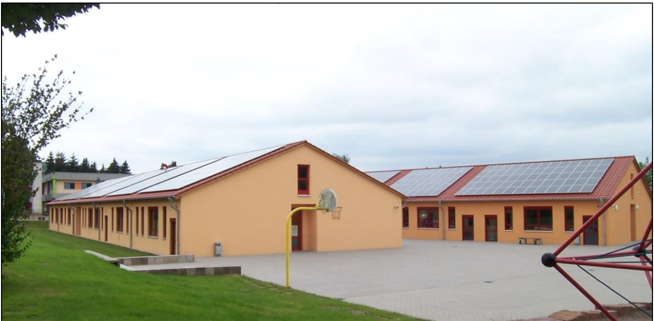
Gesamtansicht von Osten
