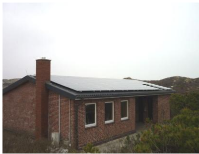
Die Solarmodule auf dem Aufenthaltsgebäude
